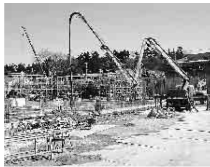
工事が進む秩父第一中学校
